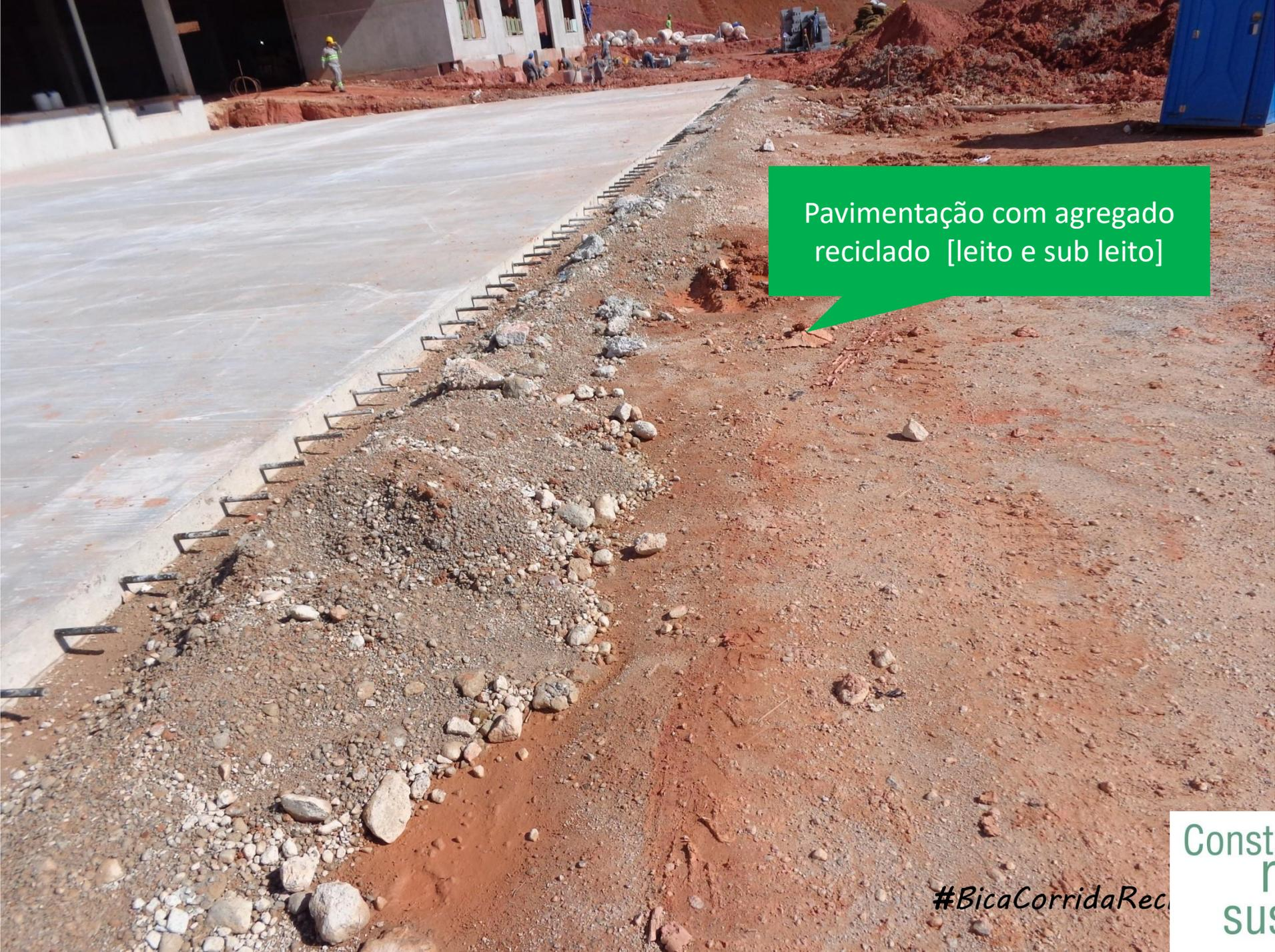
Pavimentação com agregado reciclado [leito e sub leito]
